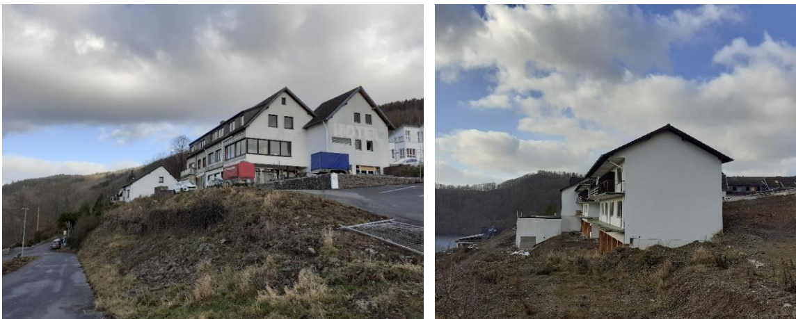
Abbildung 1 und Abbildung 2: Blick auf ehemaliges Hotelhauptgebäude (nördlich der Straße) und Nebentrakt (südlich der Straße)
